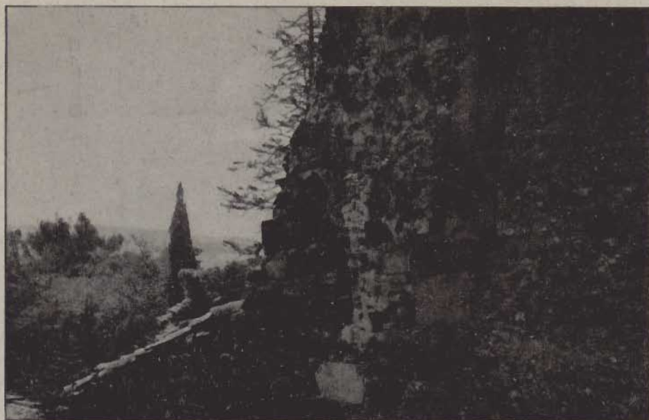
Fig. 11 Particolare della parete esterna di fondo che mette in evidenza la traccia di una successiva campata.
