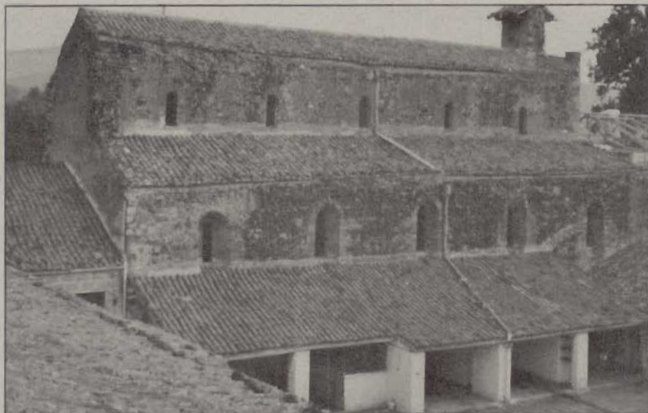
Fig. 3 la parete esterna della navata sinistra. La prima finestra di sinistra dell'ordine più basso visibilmente inserita in una parte completamente rifatta.
